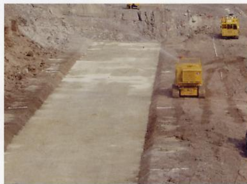
施工状況写真
